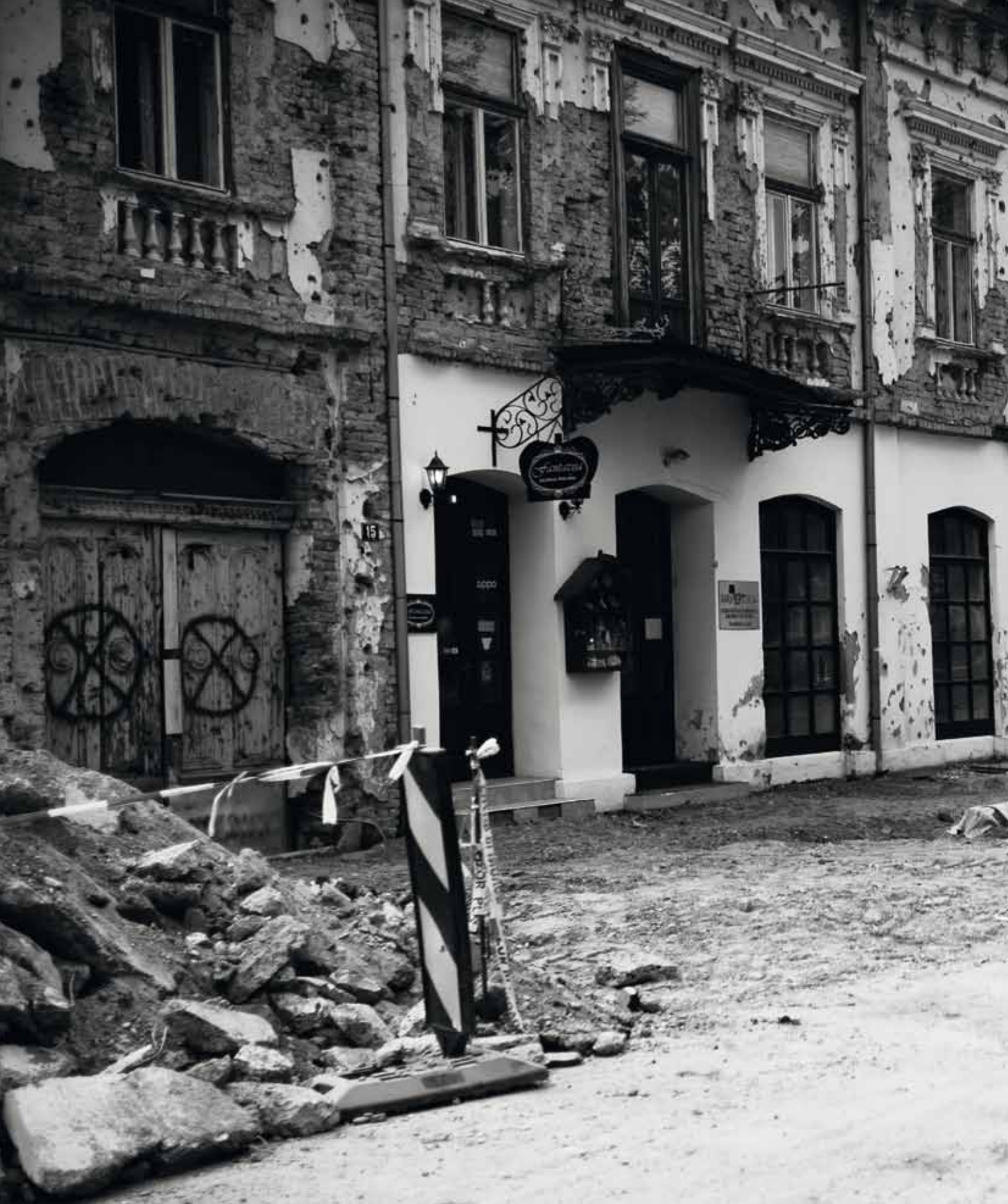
AUFGERISSE WUNDE Die ULICA JOSIPA JURJA STROSSMAYERA ist Vukovars Flanierstraße in der Innenstadt. Die Bauarbeiten ziehen sich seit Jahren hin. Die Gebäude tragen Narben des Krieges und scheinen sich selbst überlassen zu sein
